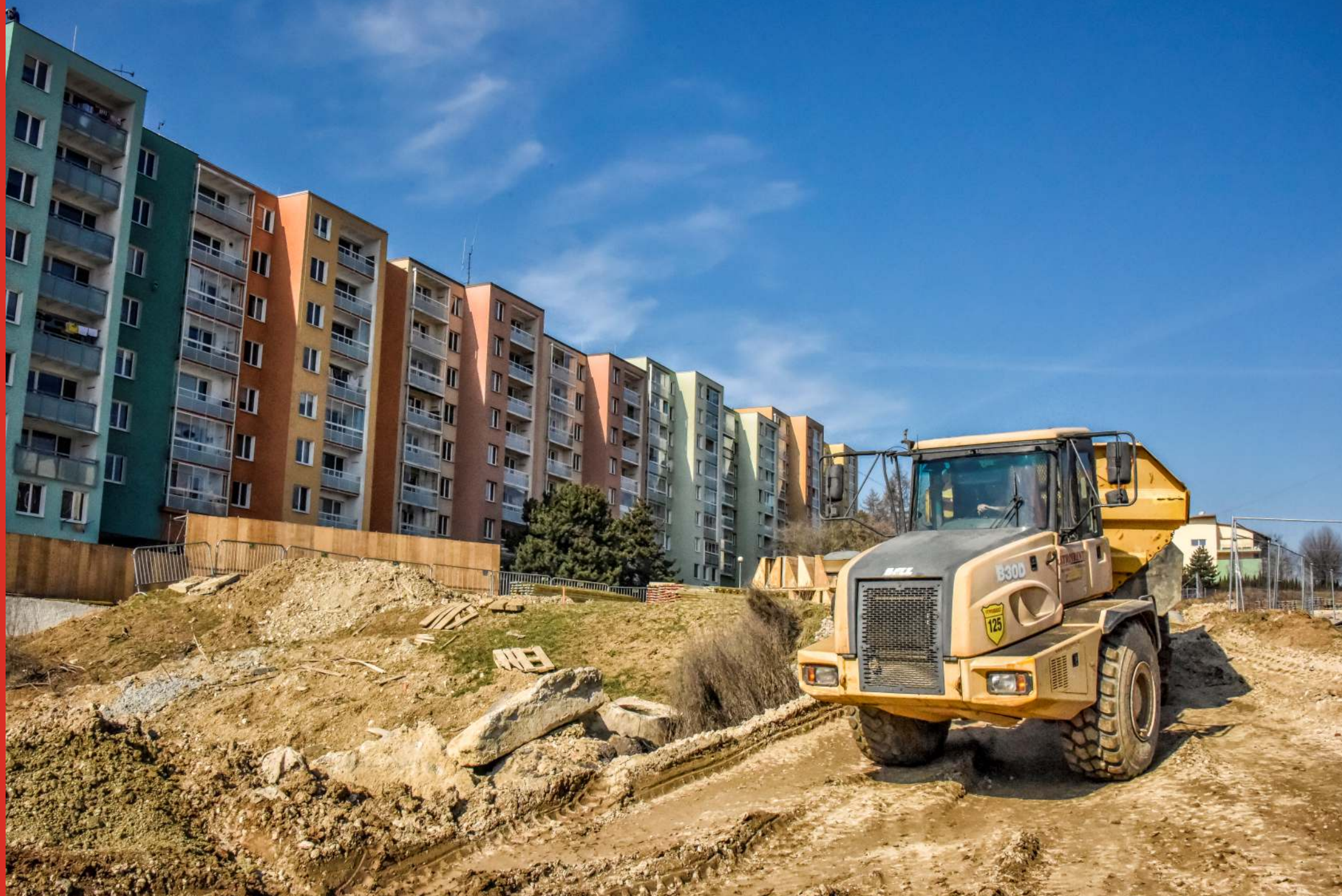
Po fázi přípravných prací nastoupila těžká technika a v dubnu 2020 započaly hlavní výkopové práce mezi ulicemi Osovou a Jihlavskou.
